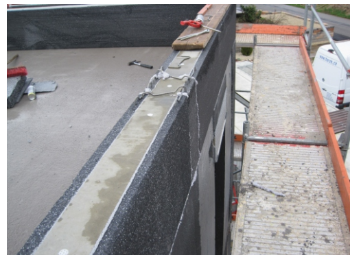
Montage auf einer bestehenden Betondecke durch Verschrauben und Fixieren mit Montageschaum
