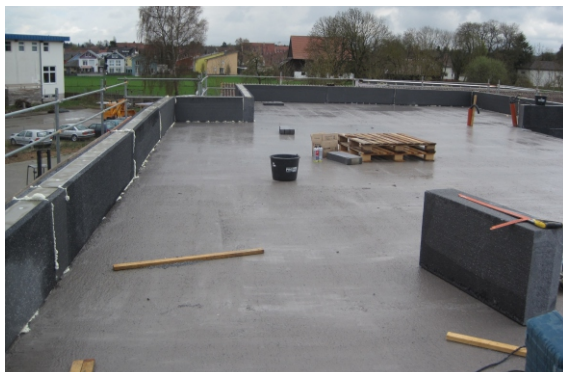
Montage auf einer bestehenden Betondecke durch Verschrauben und Fixieren mit Montageschaum
