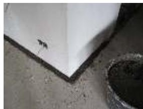
Schlitze zwischen Innenwand und Estrich lassen sich leicht schließen
