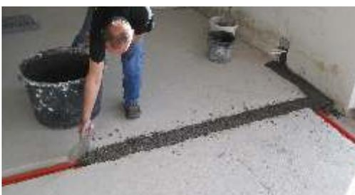
Verschließen von Leitungen und Fehlstellen im Estrich
