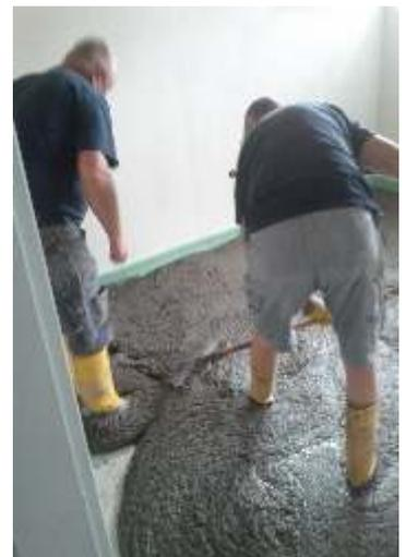
Mit dem Schlauch der Betonpumpe wird der MAGU Leichtbeton durch das Fenster direkt an den Einsatzort verbracht und eben abgezogen.
