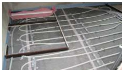
Sanierung eines Badbodens mit Bodenheizung und begehbarer Dusche
