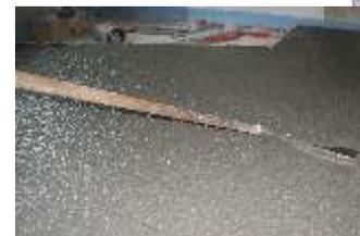
Abziehen des Leichtbeton mit der Schwabbelstange
