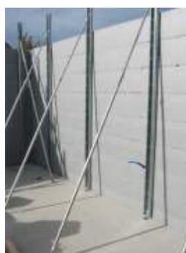
An den Diagonalauslegern kann die Wand lotgerecht ausgerichtet werden.
