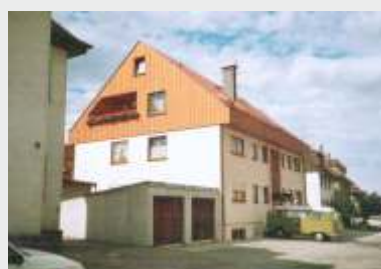
Mehrfamilienhaus 1984 in Rottweil
