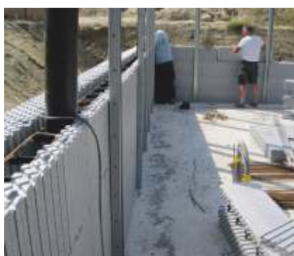
Die U-Schalen werden mit Isodübeln an den MAGU Elementen befestigt.
