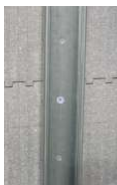
Die U-Schalen werden mit Isodübeln an den MAGU Elementen befestigt.
