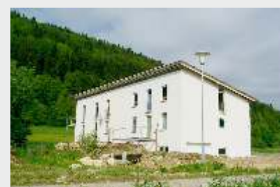
Haus mit Gewerbetrakt in Geisingen
